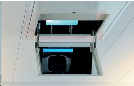
Großbild-Projektoren lassen sich per Deckenlift ein- und ausfahren
